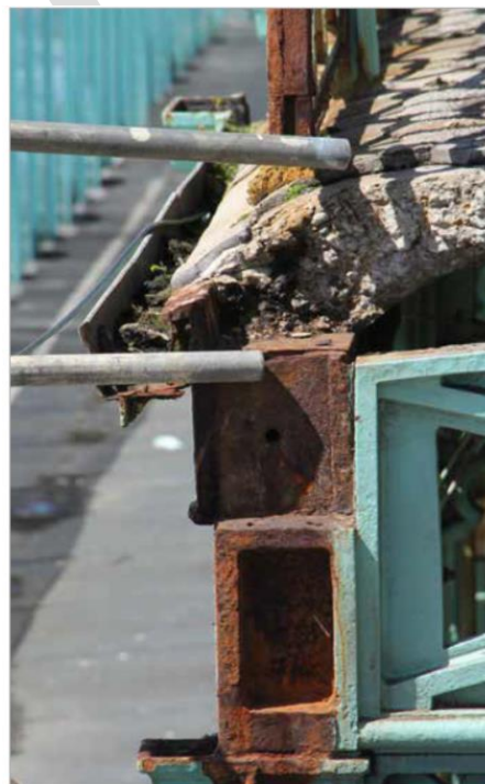
edge beam condition
