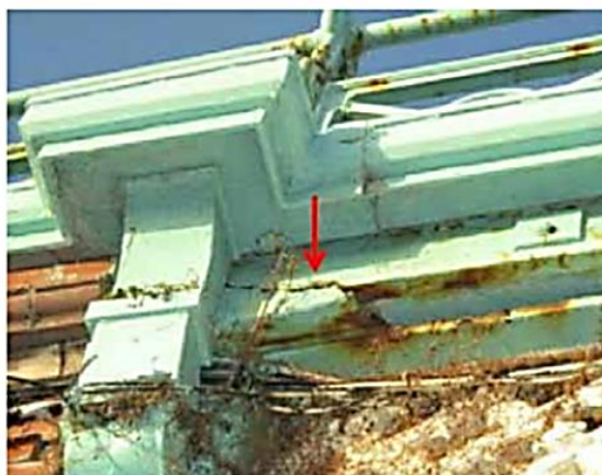
edge drainage gutters
